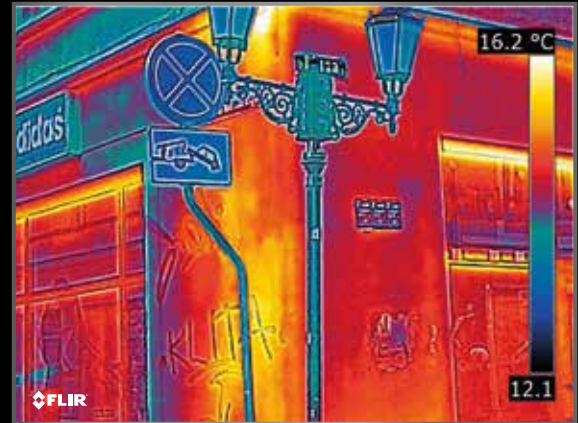
Immagine termica con MSX®
